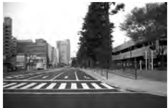
木町通交差点改良工事
