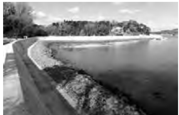
H25梅ヶ沢I地区 (県営海岸災) -A81号梅ヶ沢I 海岸外災害復旧及び農地復旧除塩工事
