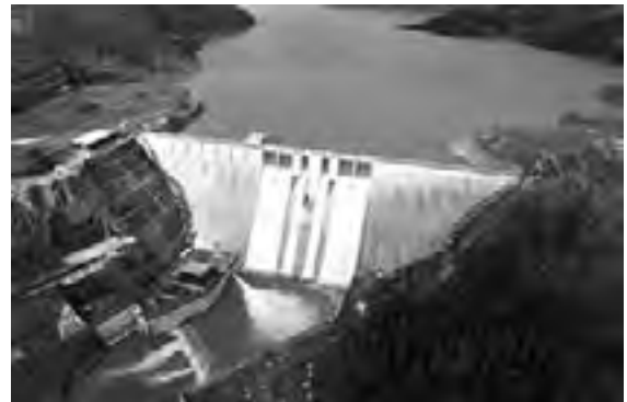
津軽ダム本体建設工事
