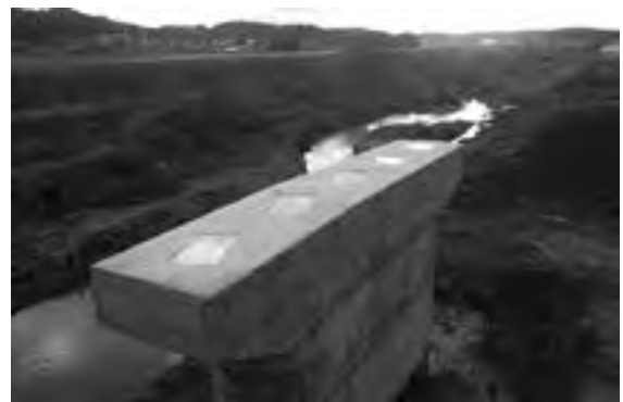
平成23年度県交安一種02101-A04号 西川橋橋梁下部工工事
