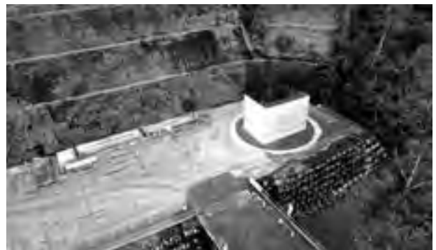
ドローンで撮影した施工現場
