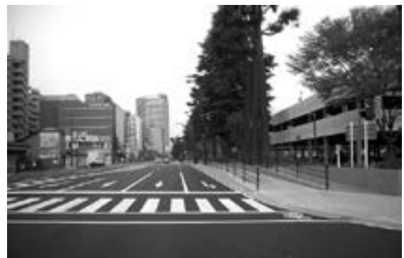
木町通交差点改良工事
