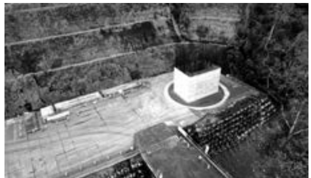
ドローンで撮影した施工現場
