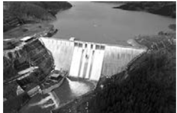
津軽ダム本体建設工事
