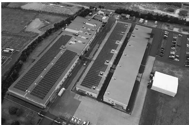
相馬工場太陽光パネル
