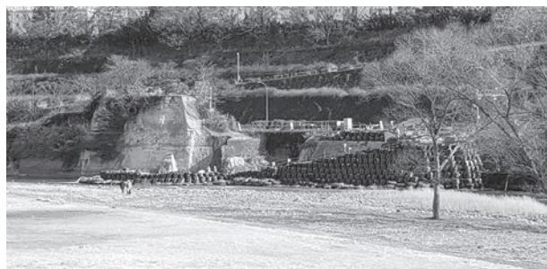
広瀬川河岸段丘を貫通する仙台西道路
