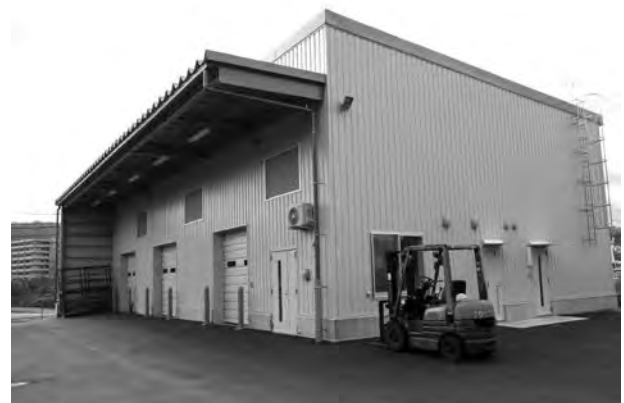
第二工場倉庫棟
