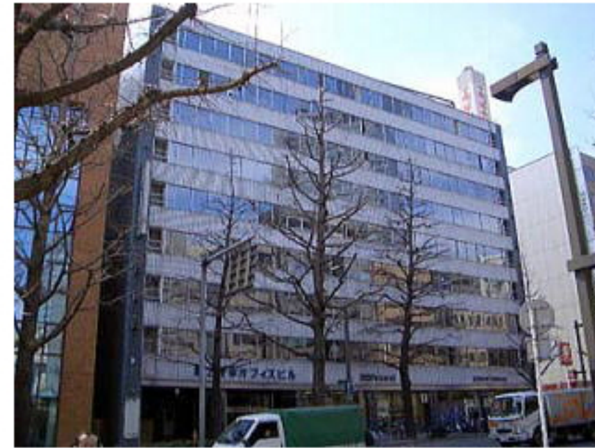
本社のある第二日本オフィスビル
