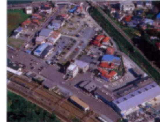
本社第一工場 第二工場・ストックヤード
