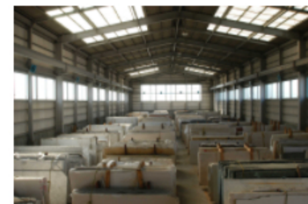
平山第2工場・ストックヤード
