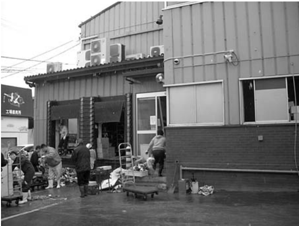
震災後の工場の復旧作業
