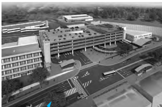
八木山動物公園駅舎
