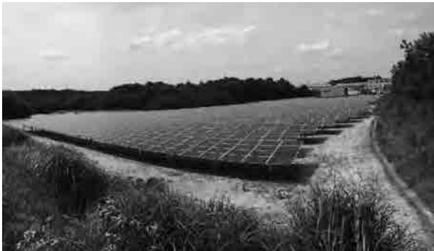
加美町にある孫沢発電所
