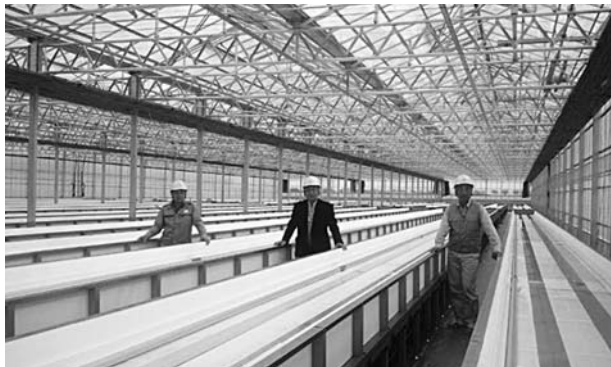
建設中のハウス内
