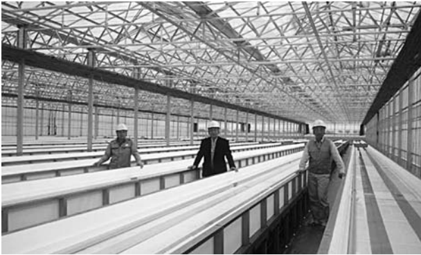
建設中のハウス内
