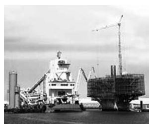
「コンクリートプラント船」
