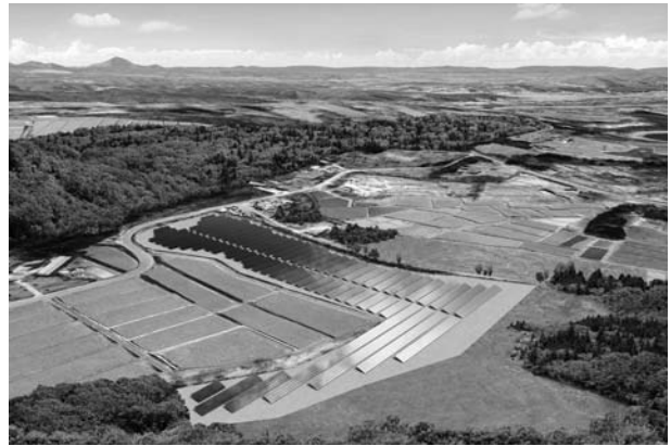
「くじらのメガソーラー発電所」
