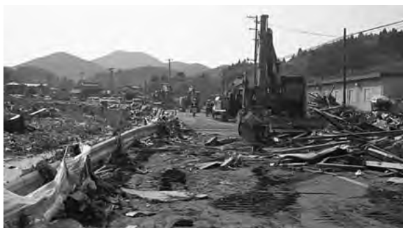
東日本大震災復旧工事
