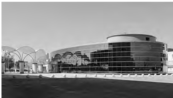
夢メッセ（震災復旧後）
