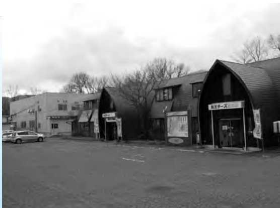
事務所・売店・工場棟
