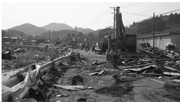
東日本大震災復旧工事
