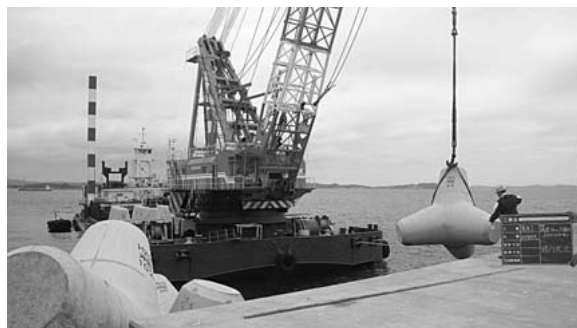
仙台港沖防波堤工事
