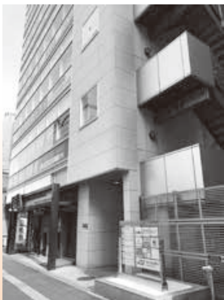
仙台本社入居ビル「ディーグランツ仙台ビル」
