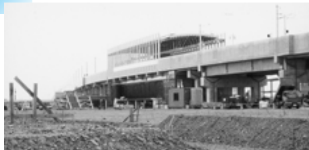
杜せきのした駅（仙台空港アクセス鉄道）の建設状況（ダイヤモンドシティはこの駅近くに建設中）
